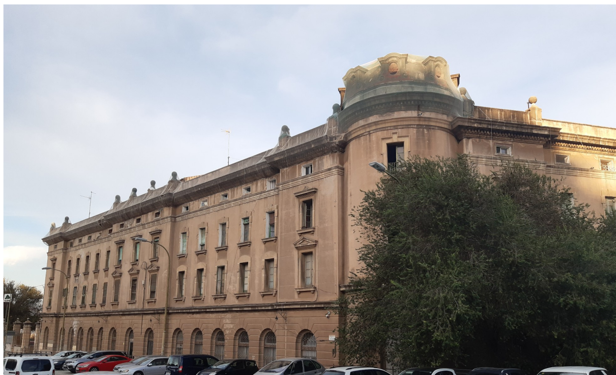
Figura 1: Estat actual de l'edifici històric de l'Estació Barcelona-Sagrera Mercaderies
