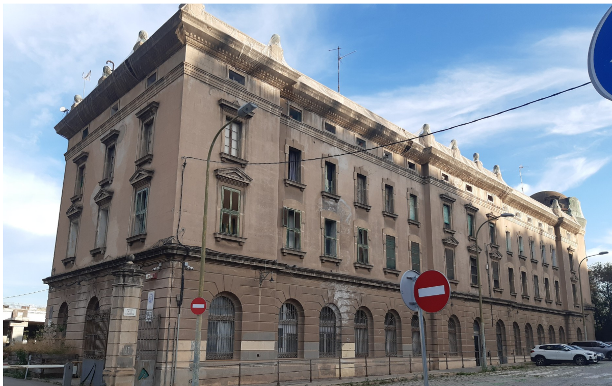
Figura 2: Estat actual de l'edifici històric de l'Estació Barcelona-Sagrera Mercaderies
